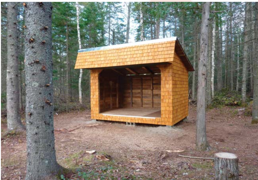
Le nouveau lean-to du sentier Saint-Bernard. Photo : Jacques Goulet
